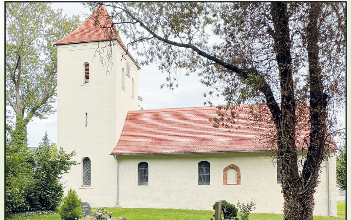
In der Dorfkirche Gersdorf wird noch gebaut.
