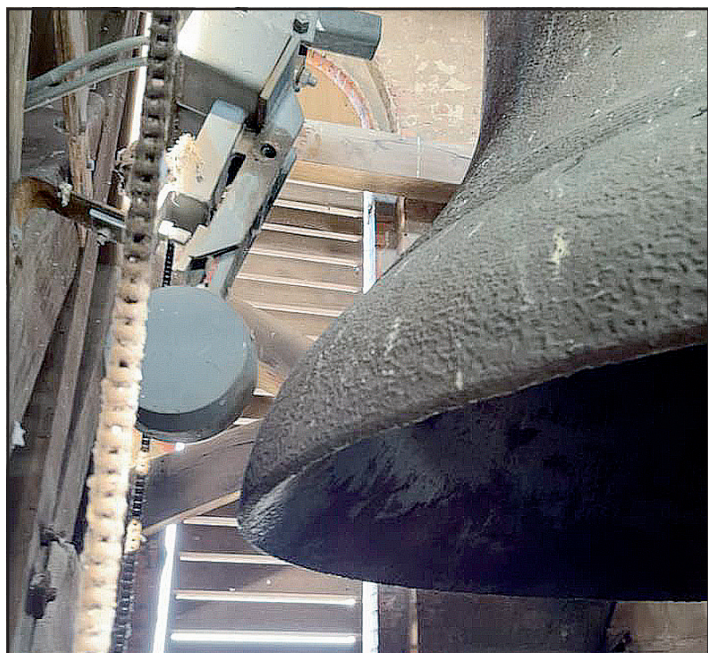
Der Antrieb der großen Glocke.
